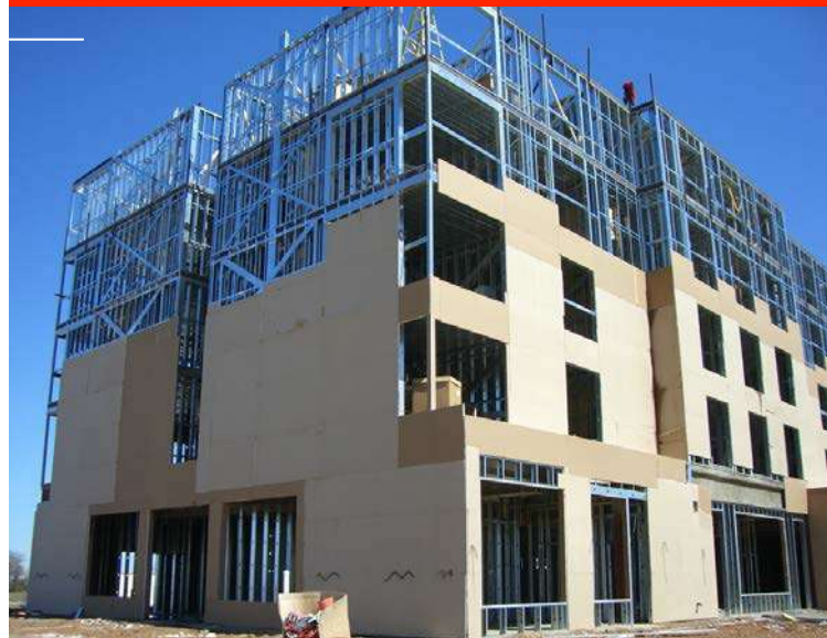
ESTRUCTURA DE STEEL FRAMING
