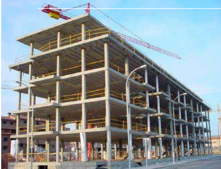
ESTRUCTURA DE FORMIGÓ
